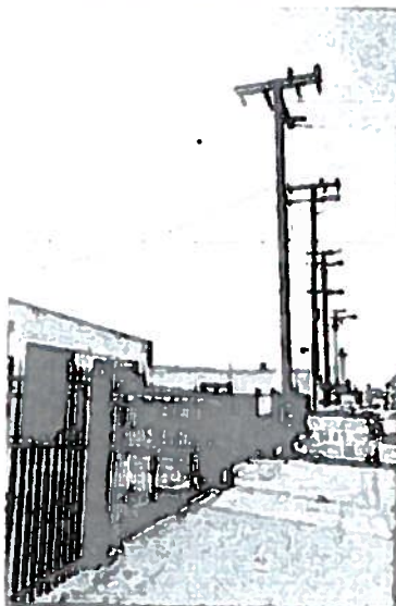
SCE Power Poles
